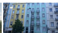
Certificado em 2014 Classe A+ Reabilitação Edifício Braamcamp nº 16 a 20, Lisboa ABC: 1 400 m 2
