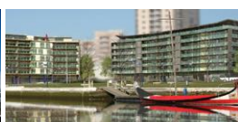
Certificado em 2011 Classe A Edifício "Mirador Lake 2", Aveiro ABC: 7 967 m 2
