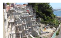
Certificado em 2012 Classe A Reabilitação da Estrada Marginal Lisboa - Cascais
