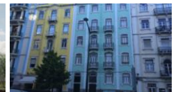
Certificado em 2014 Classe A+ Reabilitação Edifício Braamcamp n.º 16 a 20, Lisboa ABC: 1 400 m 2
