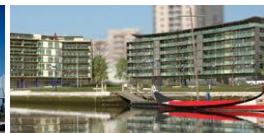
Certificado em 2011 Classe A Edifício "Mirador Lake 2", Aveiro ABC: 7 967 m 2
